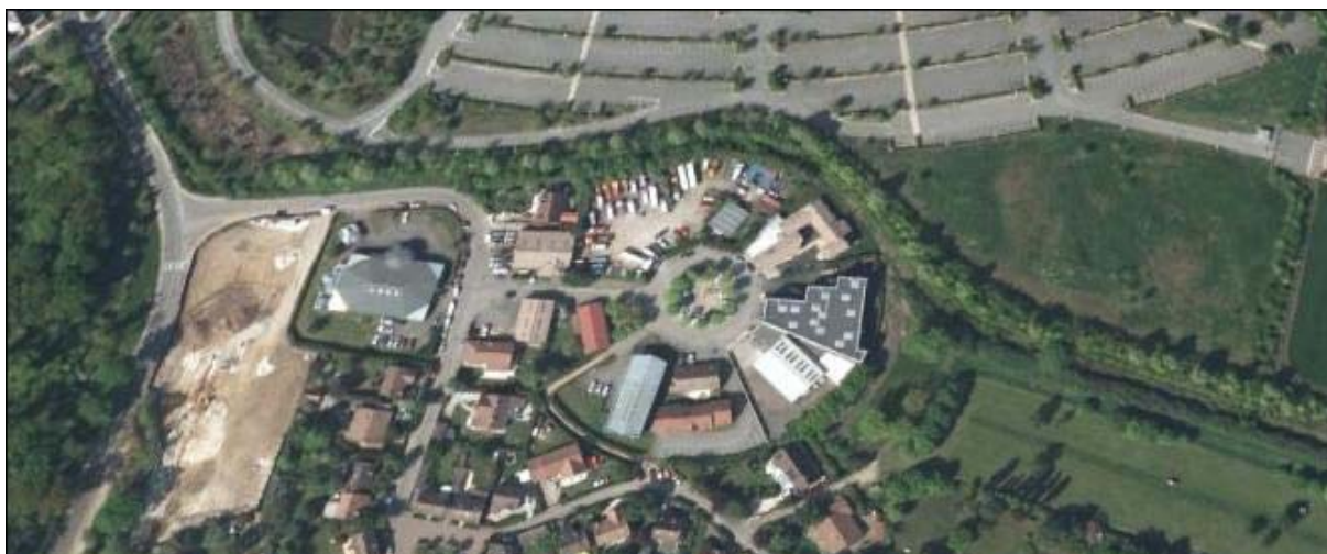
Route départementale n°5, section AA, parcelle 3 : haie
